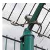
Mise à la terre avec poteaux AXIS®
