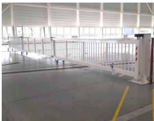
Portail pivotant manuel de grand passage à vantaux repliables sur eux-mêmes en «portefeuille».
