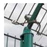
Mise à la terre avec poteaux AXIS®
