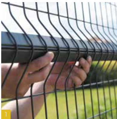
1 Positionnez un renfort dans le premier pli du panneau (haut).
