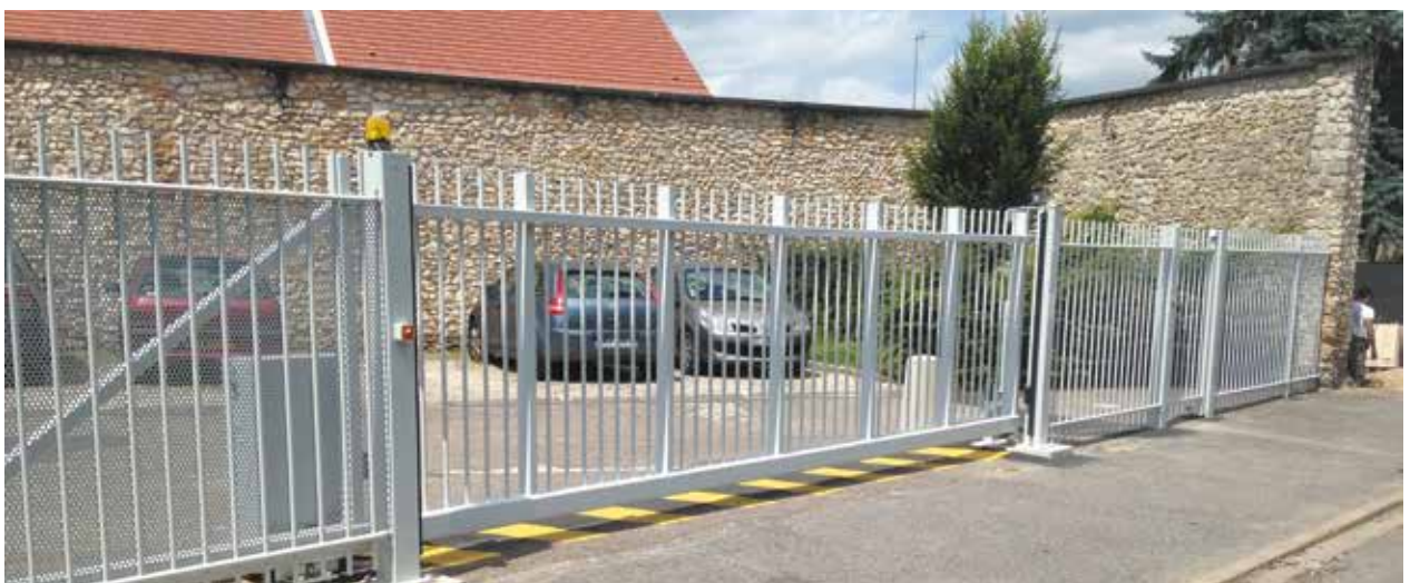
Protection de la zone de refoulement d'un portail autoportant par intégration d'une tôle perforée
