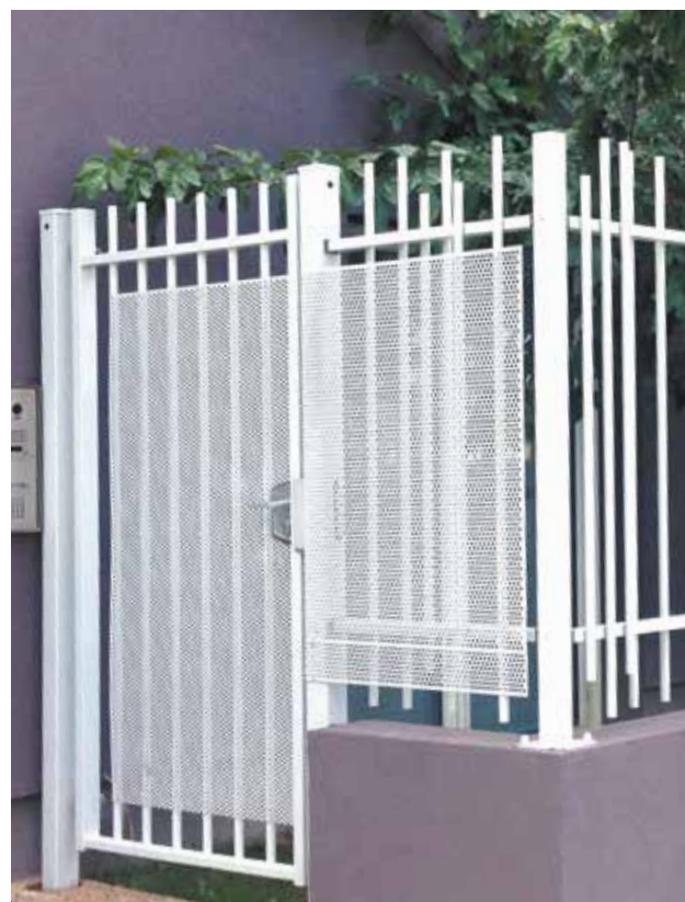
Portail pivotant avec protection de la serrure en tôle perforée
