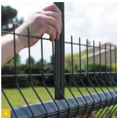
4 Glissez les lattes de 48 mm dans chacune des mailles jusqu'au remplissage complet du panneau.
