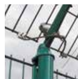
Mise à la terre avec poteaux AXIS®
