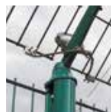
Mise à la terre avec poteaux AXIS®
