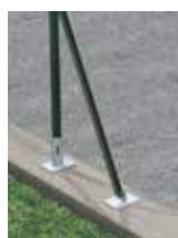
Platine pour jambe de force de section 25 mm
