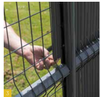
3 Repérez les deux lattes d'extrémité (45 mm). Glissez-la dans la première maille de chacune des extrémités du panneau, languette opposée au pli .
