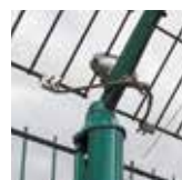
Mise à la terre avec poteaux AXIS®
