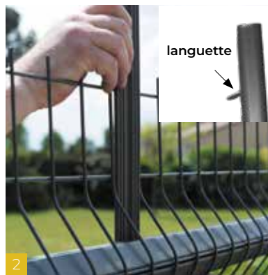
2 Glissez une latte (48 mm) languette opposée au pli , dans une maille au centre du panneau pour maintenir le renfort. Glissez-la jusqu'aux plis suivants. Répétez l'opération pour chacun des plis.
