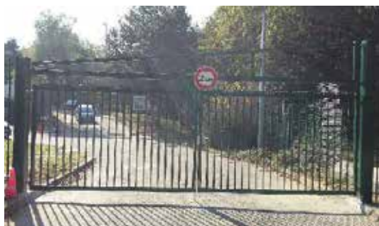
Portail pivotant manuel à imposte amovible pour réduction de hauteur.
