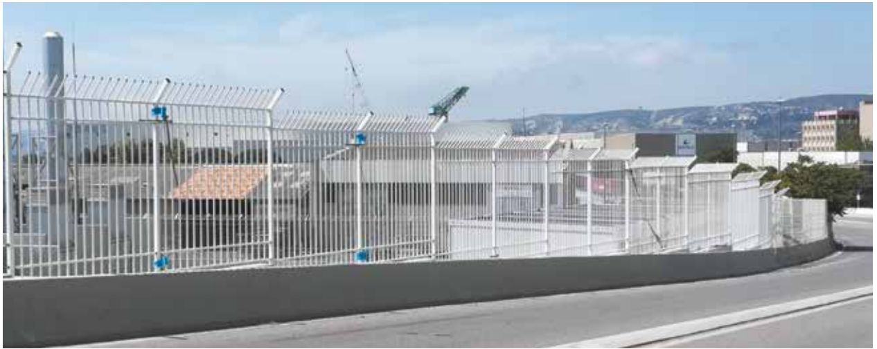
Grilles barreaudées avec bavolets inclinés et intégrés.
